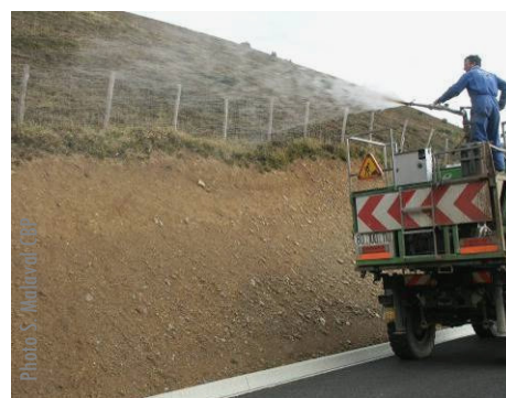
Figure 2 : restauration d'un talus par semis hydropropulsé (hydroseeding)
