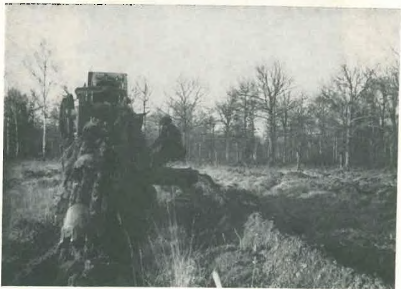
XI. Excavatrice à godets John Allen ouvrant une tranchée dans un vide. (Cl. PLAISANCE.)
