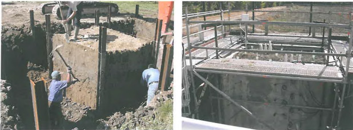
Figure 5 : Photographie du lysimètre en cours de réalisation et actuel
