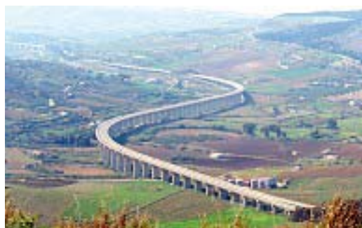
Une nouvelle conception du système autoroutier : tunnels et viaducs à la place de déblais-remblais. (c) Jean-Claude Lefeuve
