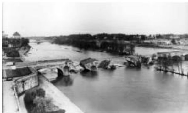
Figure 2 Le pont Wilson effondré à Tours (archives départementale d'Indre et Loire, cliché Arsicaud, extrait de Catalon, 2015)
