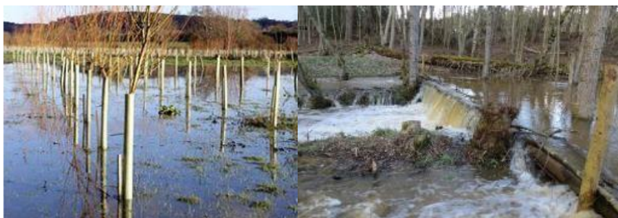
Figure 106 Plantations dans la plaine inondable et petits barrages de bois sur les ruisseaux pour faciliter les débordements dans la plaine (photos extraites de Environment Agency, 2013) ©www.petersmith.com
