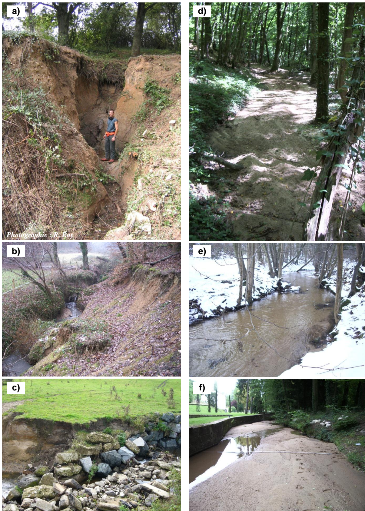
Figure 1 : exemples de tronçons incisés ou ensablés : a) chenal incisé (Goutte des Verrières) ; b) glissement de terrain initié par l'incision du chenal (Goutte des Verrières) ; c) déstabilisation d'un enrochement induite par une incision (Chaudanne) ; d) engorgement du chenal à pleins bords en aval d'une incision (Ribes) ; e) ensablement du lit de l'Yzeron ; f) ensablement du lit du Charbonnières
