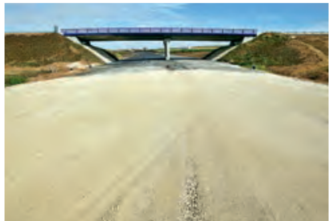
Déviations de la route nationale 10 à l'entrée nord d'Angoulême. © Thierry Degen.
