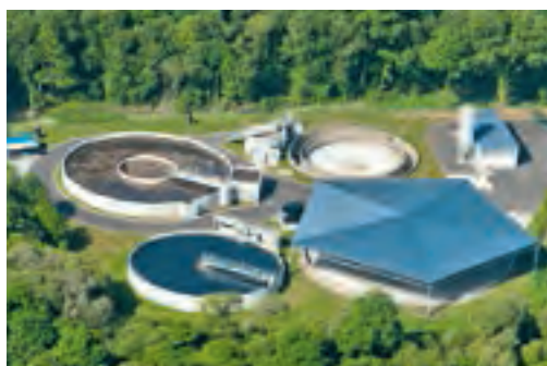
Station d'épuration. © Laurent Mignaux.
