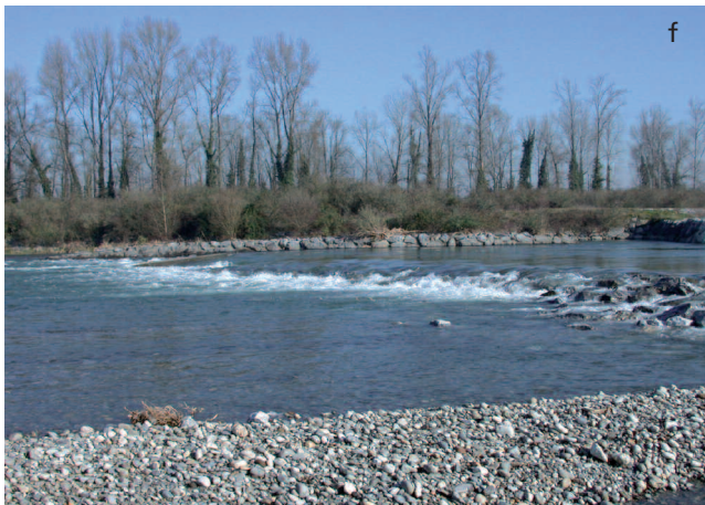
(e) (f) Exemples de seuil de stabilisation de lit installés sur le gave de Pau et permettant d'éviter l'incision du lit.
