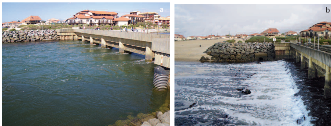
Exemple du Lac Marin (sur le Courant de Soustons dans les Landes). (a) au flot, la mer rentre en amont de l'obstacle (lac), (b) au jusant, un seuil permet de retenir l'eau pour éviter que le lac ne se vide.
