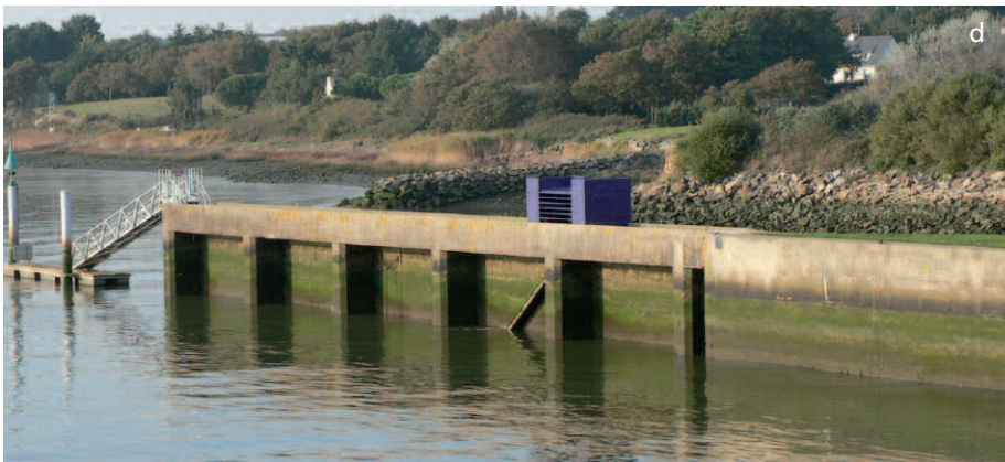
Exemples de passes estuariennes. (a) et (b) Passe à poissons à l'intérieur de la buse estuarienne de la Durdent, (c) et (d) passe piège à anguilles au barrage d'Arzal sur la Vilaine.
