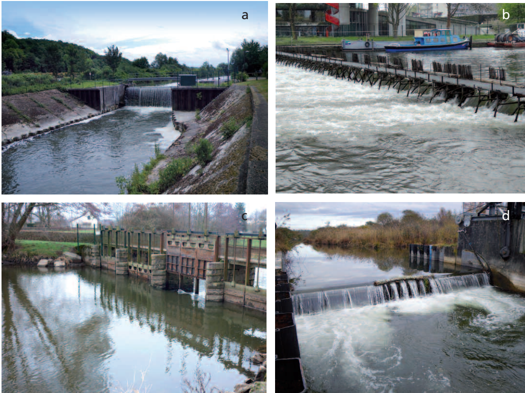
Exemples de seuils mobiles. (a) Ouvrage constitué d'une vanne levante avec écoulement par surverse et en sousverse (seuil de La Vilette à Louviers sur l'Eure), (b) ouvrage à aiguilles (Robertsau à Strasbourg sur l'Ill), (c) seuil constitué d'une série de vannes levantes (vannages du camping d'Autun sur le Ternin), (d) seuil constitué d'un clapet déversant (seuil de Probert sur le courant de Ste Eulalie).
