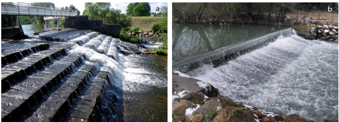
Exemples de redans au niveau d'un seuil incliné. (a) Succession de redans, (b) Redan en amont d'un seuil incliné.
