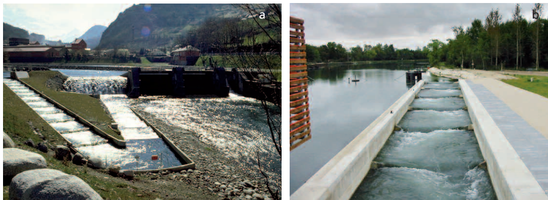
Exemples de passes à échancrures triangulaires. (a) Passe à seuils triangulaires de Sarrancolin sur la Neste, (b) passe à seuils triangulaires de Jaulnes sur la Seine.
