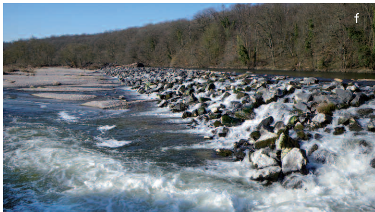
Exemples de seuils fixes. (a) Seuil vertical, (b) seuil présentant une succession de redans, (c) seuil incliné présentant un redan en amont, (d) seuil incliné, (e) seuil en enrochements à faible pente, (f) seuil en enrochements à forte pente.
