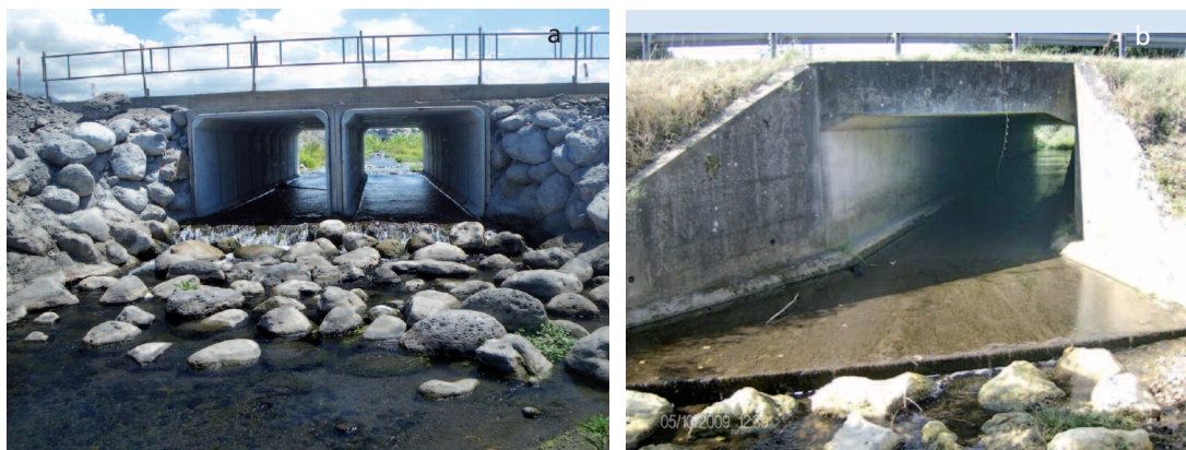
Exemples de faibles tirants d'eau au niveau de deux radiers sous ponts routiers.
