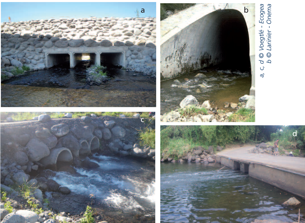
(a) Exemple de passage routier muni de dalots, (b) exemple de passage routier présentant un radier avec enrochements, (c) passage routier muni de buses, (d) passage routier muni de dalots.
