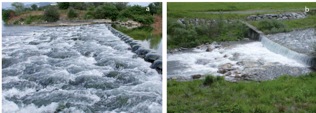
Photos de seuils en enrochements avec redans.
