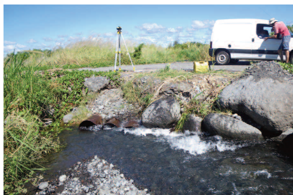
Exemples de mises en vitesse en amont de passages busés.
