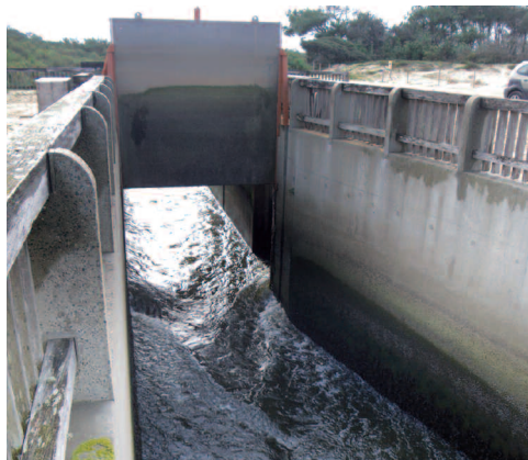
Exemple de vannage. Vanne levante installée sur le courant de Soustons dans les Landes.
