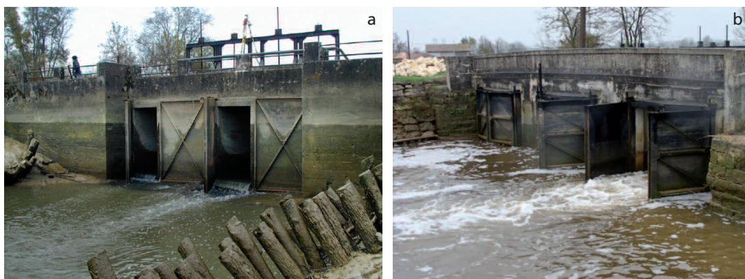
Exemples de portes à flots. (a) portes à flots installées sur le marais d'Arcins en Gironde. (b) portes à flots installées sur la Livenne.
