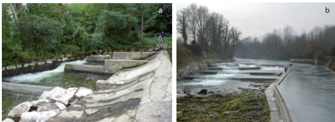
Exemples de prébarrages. (a) Prébarrages au barrage de Guilhot sur l'Ariège, (b) prébarrages au barrage de Gurmençon sur le gave d'Aspe.
