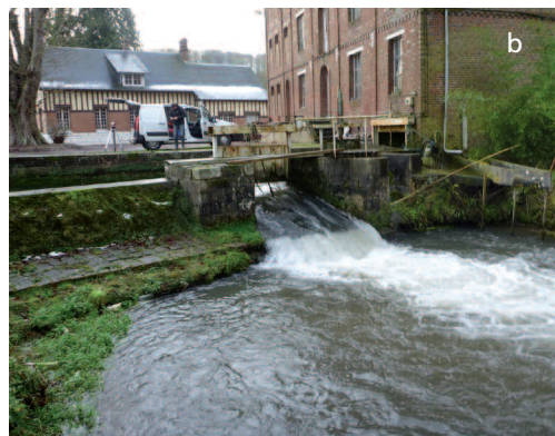
Shémas et exemples de vannes en charge et non en charge. (a) Photo d'un écoulement sous vanne en charge, (b) Photo d'un écoulement au niveau d'une vanne qui n'est pas en charge.
