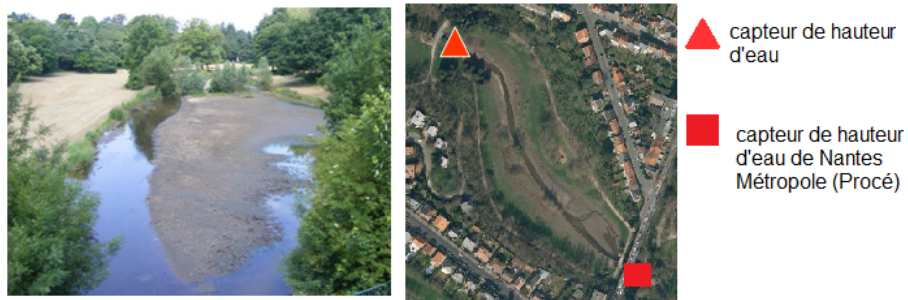
FIGURE 2.17 – Photos du bassin de stockage au Parc de Procé (LCPC, 13/01/2008).
