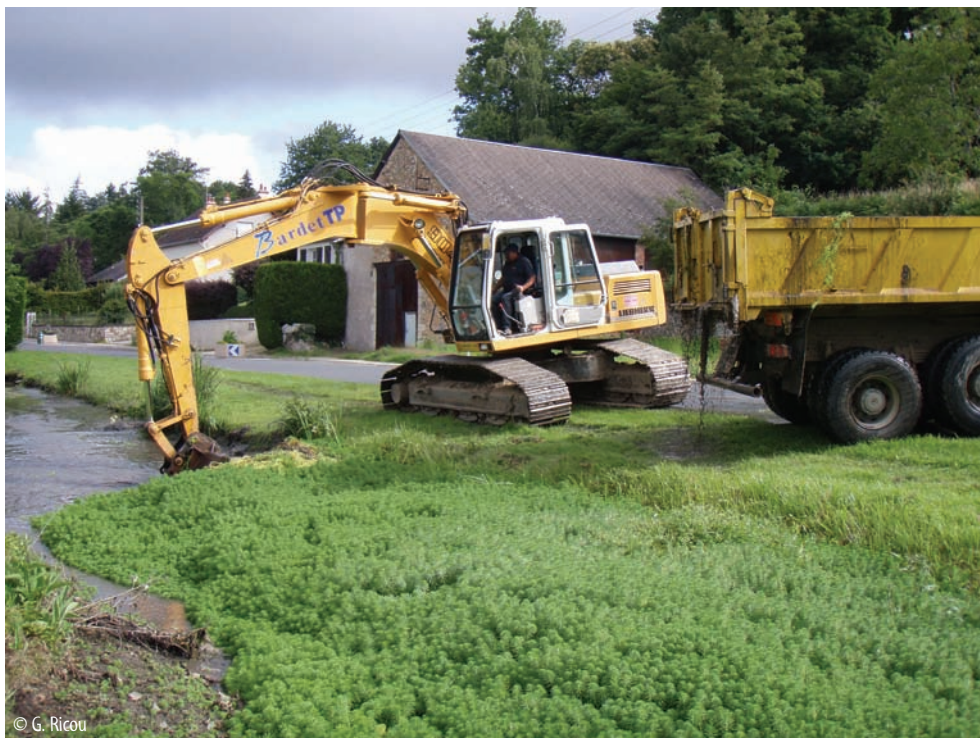
Arrachage mécanique de myriophylle du Brésil sur le ruisseau du Saulay (37)
