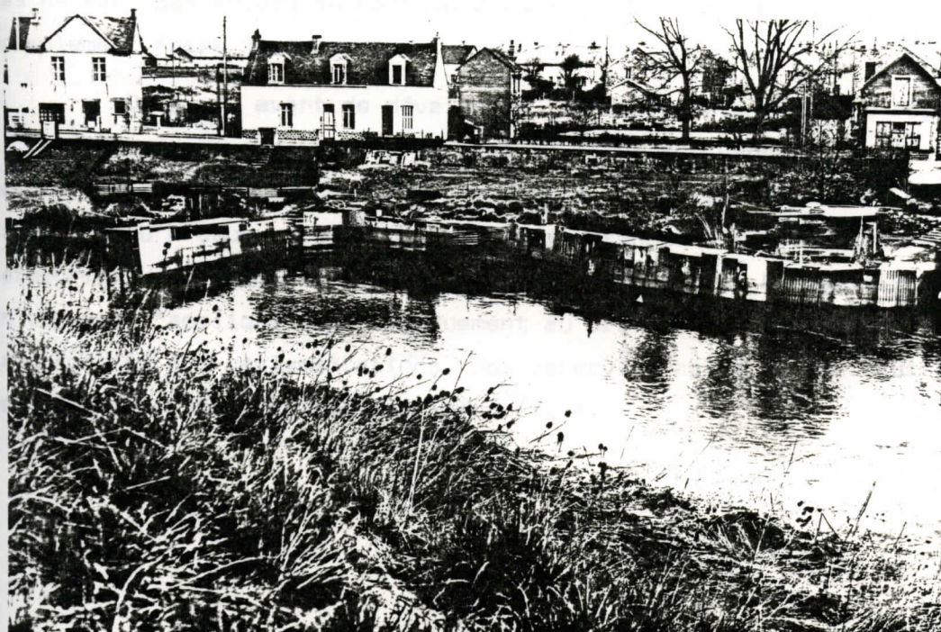
Photo 6 : Berge artificielle surnuméraire avec déflecteur (type collectif). Grande pêcherie de Bellevue en mars 1980
