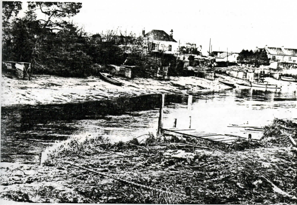
Photo 3 : Obstacle de type "estacades" sur les bords du Brivet en aval des vannages de Méan (Mars 1980).
