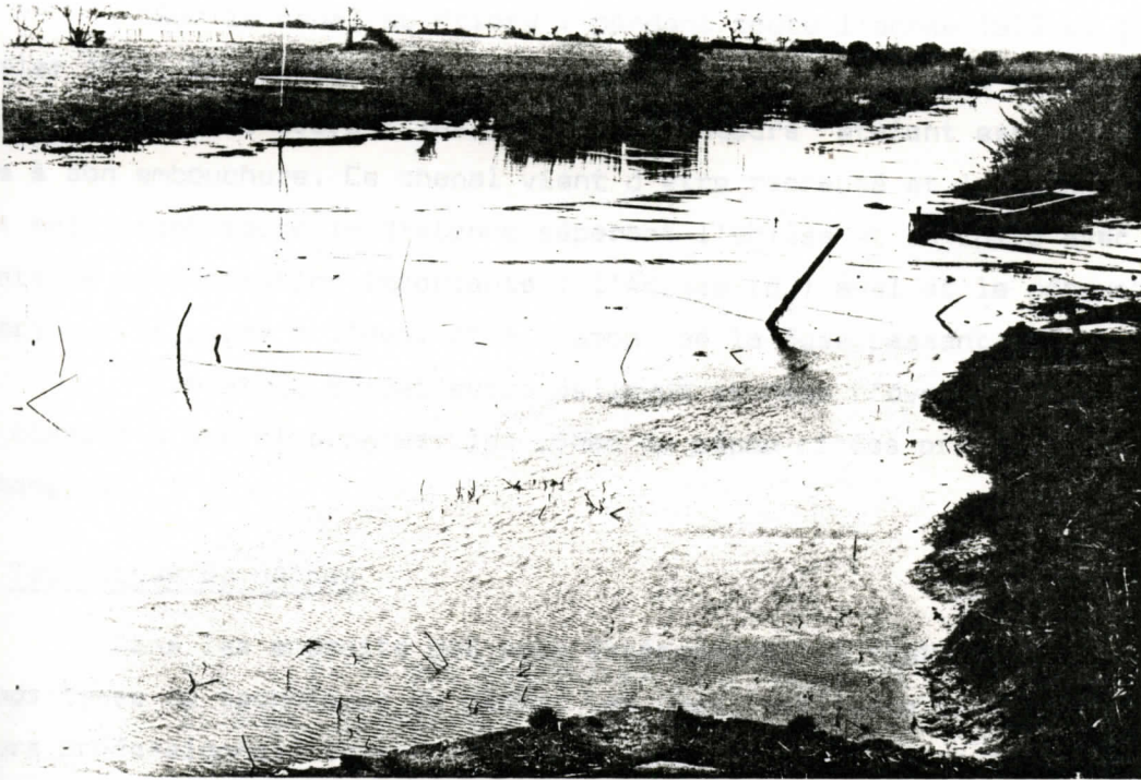
Photo 1 - Vue du canal de la Taillé en aval des écluses (Mars 1980).
