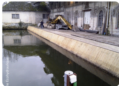
Un exemple de prise d'eau équipée d'un plan de grilles à faible espacement libre entre barreaux : l'ouvrage de Chamberlante testé sur la Dronne ■ Pôle Écohydraulique
