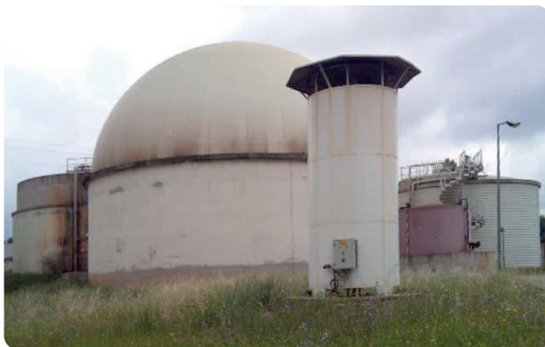
Unité de méthanisation des boues sur la STEU d'Aix-la Pioline ■ Irstea
