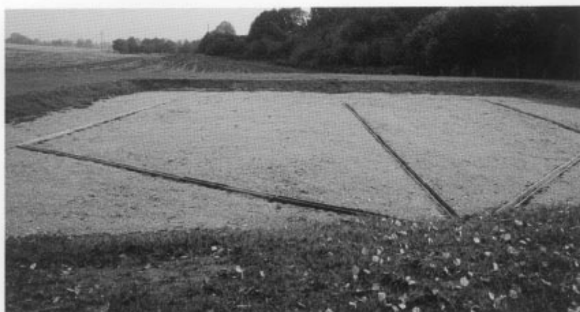
Réseau de goulottes de répartition à Savignies (60).
