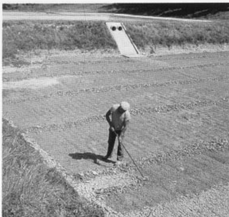
Entretien manuel d'une plage d'infiltration : les copeaux sont mis en andains puis enlevés par le préposé (Fontette - 10).
