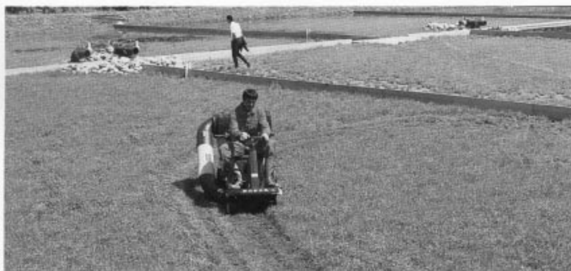
Aubenas (07) : Entretien de plages d'infiltration végétalisées.
