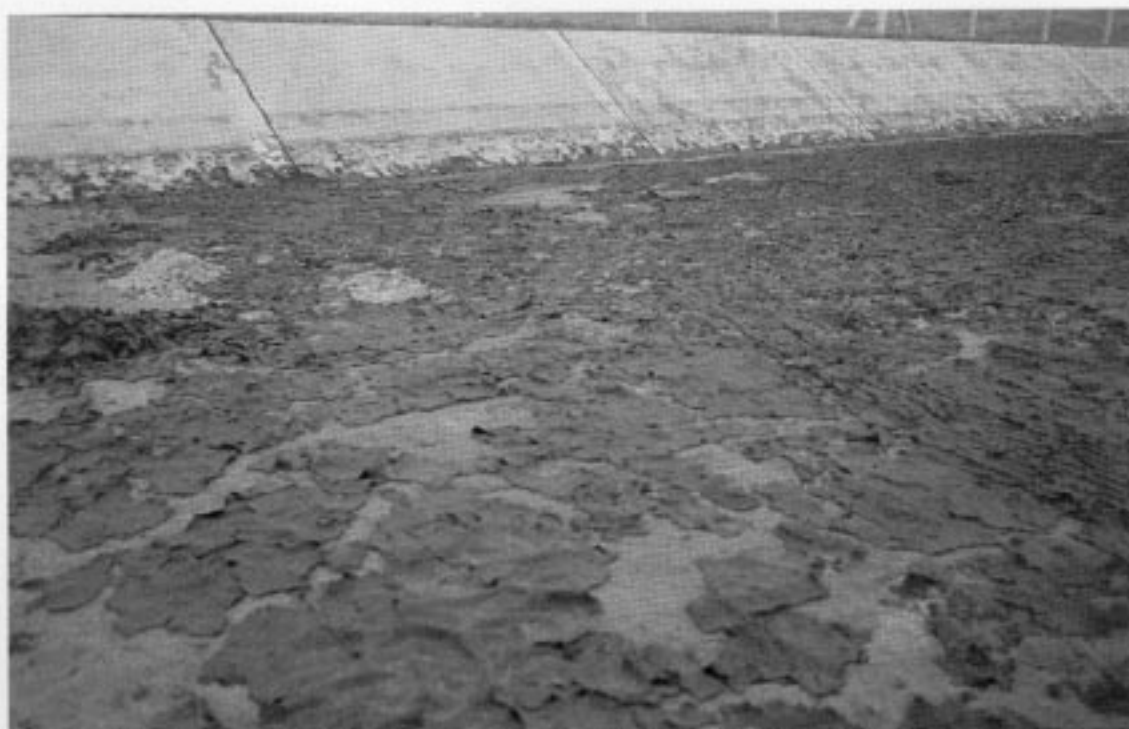
Installation de Créances (50) - Plage d'infiltration en cours de séchage après un colmatage superficiel très important. On distingue la transformation des dépôts organiques en une croûte qui se craquelle et qui sera facilement rôtissée par le personnel d'entretien.
