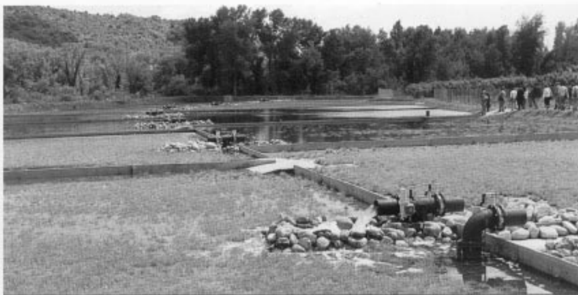
La station d'infiltration d'Aubenas (07) est découpée en 15 unités élémentaires.
