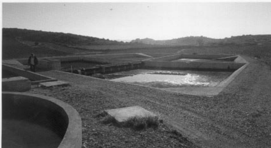
Montpeyroux (34) : On distingue, au premier plan et en arrière plan, les plans inclinés d'accès des engins d'entretien dans les bassins.
