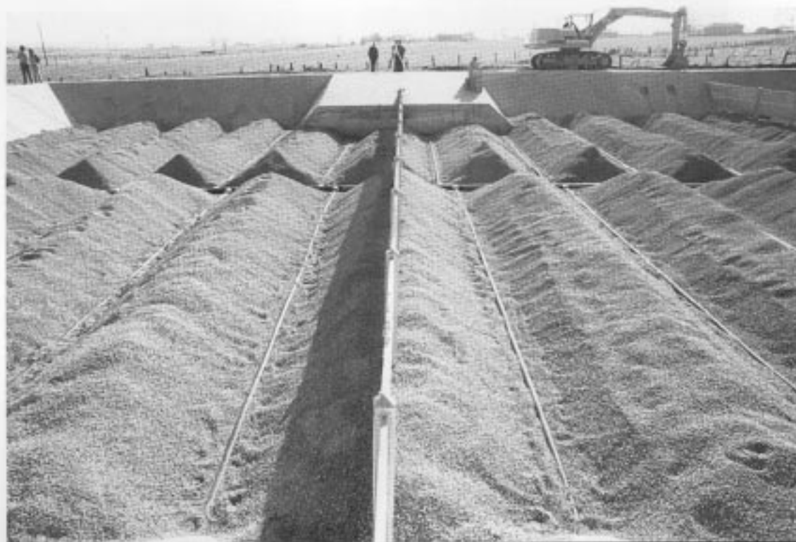
Saulxures les Vannes [54] : Mise en place du massif drainant.
