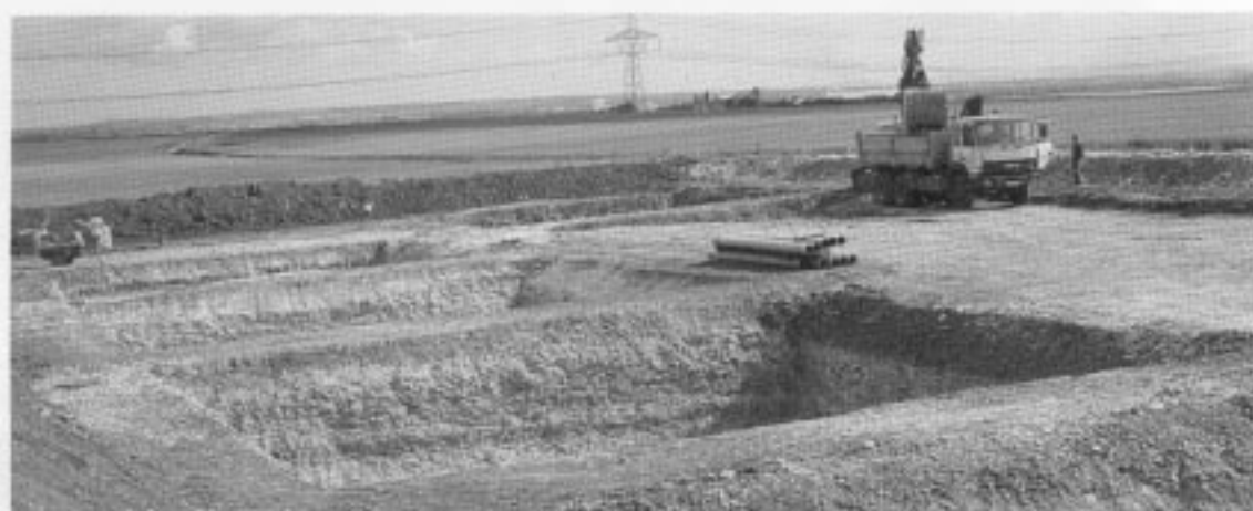
Creusement des bassins de Garcelles Secqueville (14).
