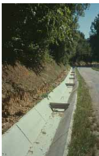
Photographie 17 : exemple de cunette en bordure de route, barrée par des seuils surélevés pour ralentir les écoulements les plus intenses (commune de Gaillardbois-Cressenville, Eure)
