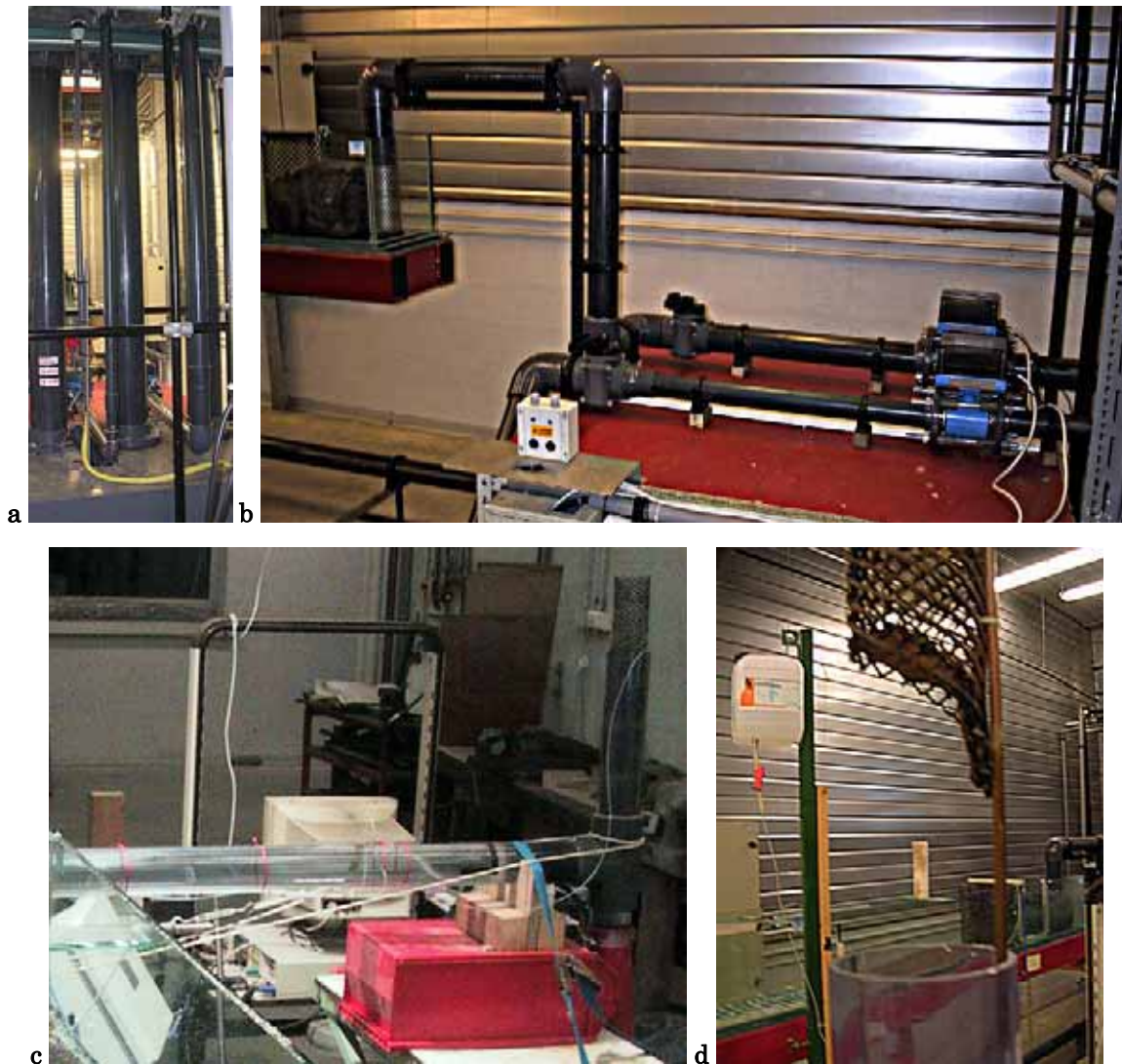
Planche 10 : vues des conduites d'alimentation. (a) descente depuis le bac surélevé ; on distingue à gauche la canalisation d'alimentation de la conduite, à droite celle alimentant le canal, au deuxième plan les colonnes déversantes, en fin se terminant par un tuyau jaune la canalisation de vidange du bac surélevé (b) tronçons horizontaux en pied de bac surélevé ; on distingue à droite les compteurs électro-magnétiques, à gauche les vannes papillon. La canalisation de plus gros diamètre alimente le canal, celle de petit diamètre reprend un diamètre de 90 mm, et rejoint le sol pour atteindre la conduite. (c) raccordement de la gaine pompier (en bas à droite) à la conduite (à gauche). On distingue le tube transparent vertical de mise à la pression atmosphérique, et le cylindre en grille plastique qui maintient le déflecteur face à la conduite (d) détail du déflecteur perméable et de la grille plastique, sortis du T de raccordement
