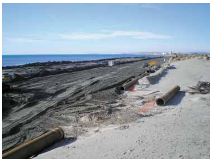
Photo 3 – Rechargement en sable, plage de Carnon. © R. Vianet, PNR de Camargue
