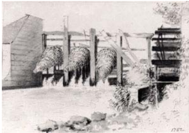
Figuur 36 Bij Engelse watermolens werden wilgentenen manden gebruikt voor de schieraalvangst. Hier een tekening van de watermolen bij Iffley.
