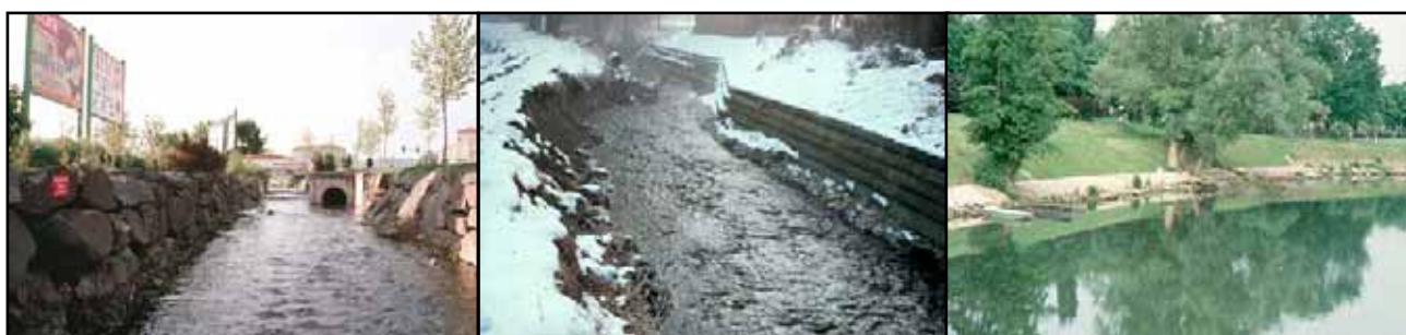
Figure 4. Illustrations de berges artificielles inadaptées : murs en enrochements, palissades en bois, perrés bétonnés, etc. (photos Biotec).
