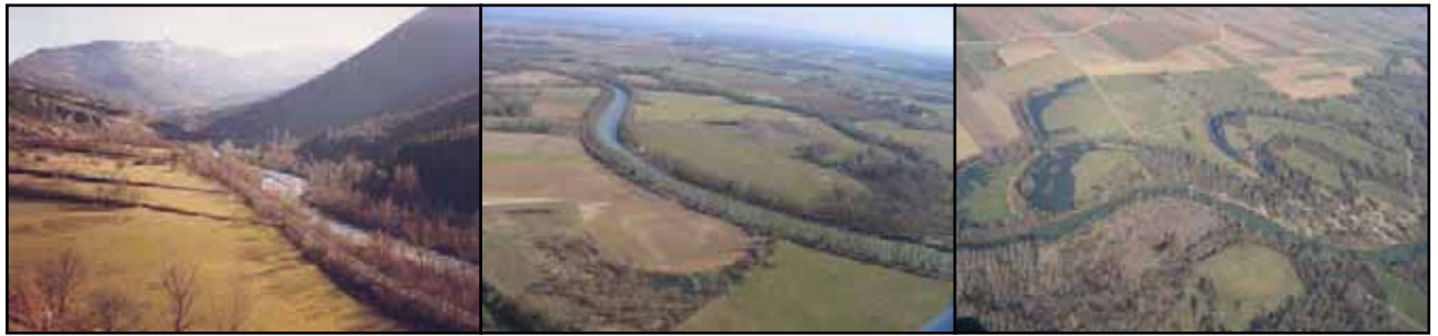
Figure 22. Exemples de lits majeurs déconnectés de leur lit mineur sous l'effet d'une chenalisation couplée à un endiguement (photos Malavoi).
