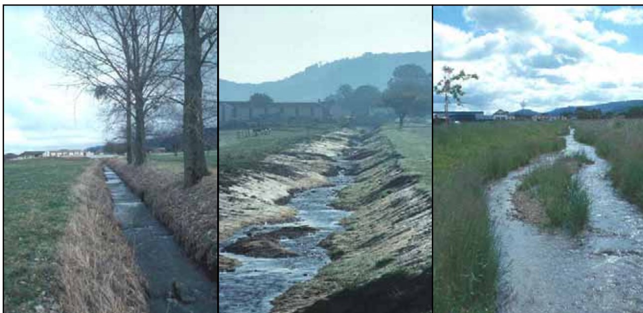
Figure 61. A gauche : (14.02.00) Etat de la Cornoline avant travaux avec pieds de berge et seuils en béton, tracé rectiligne et végétation très peu diversifiée. Au centre : (27.09.01) Etat à la fin des terrassements avec la création de berges en pente douce et variées, ainsi que la création d'îlots. A droite : (10.06.02) Etat une année après les travaux avec le développement des plantes héliophytes (semi-aquatiques) qui permettent de stabiliser les pieds de berge et de diversifier la flore locale (photos Biotec). Niveau d'ambition R2.
