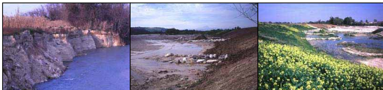
Figure 67. Rivière "Esino" à Jesi, province d'Ancône; illustration de techniques combinées en protection de berge de cours d'eau; illustration de gauche avec une érosion dynamique avant travaux, au centre des épis déflecteurs en cours de réalisation et à droite peu de temps après le chantier. Source : bureau IRIS, stratégie pour l'environnement, Maurizio Bacci ( www.irisambiente.it ).
