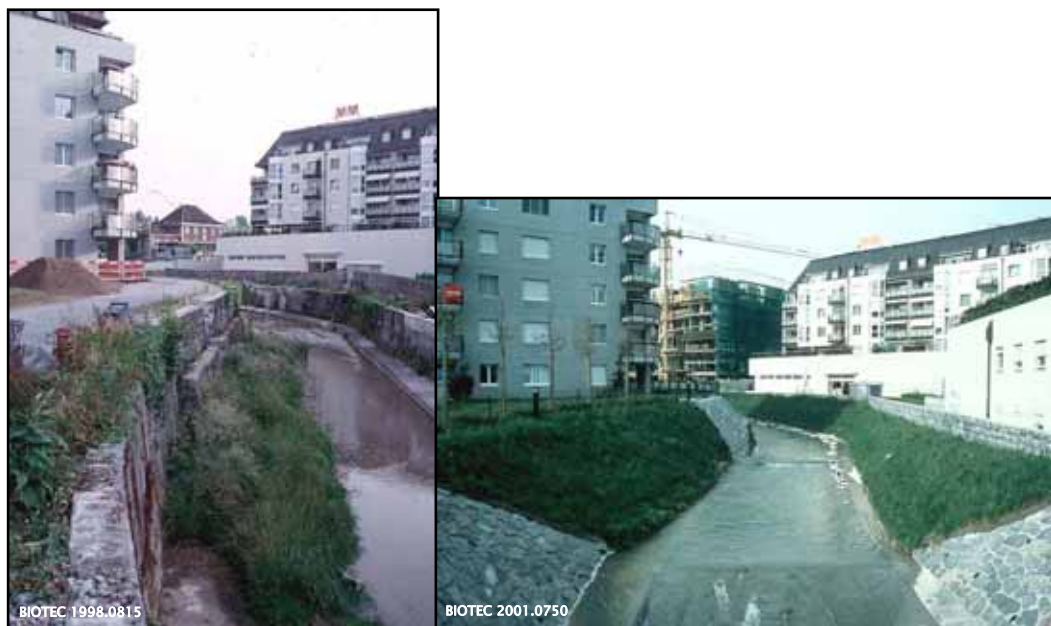
Figure 37. Exemple d'élargissement hydraulique d'un cours d'eau (la Morges en traversée de ville en Suisse) et réaménagement du lit sous forme de petits seuils, végétalisation partielle des berges, etc. A gauche état initial, à droite deux ans après les travaux (photos Biotec).
