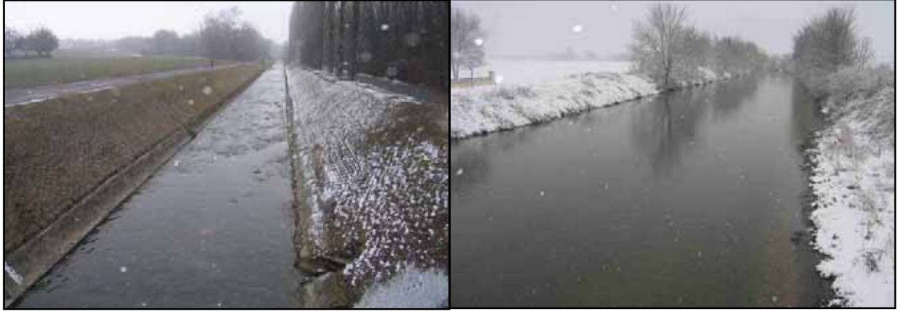
Figure 10. Exemples de cours d'eau recalibrés, rectifiés et endigués (voire bétonnés); photo de gauche l'Aire dans le canton de Genève en Suisse et photo de droite l'Ouche en aval de Dijon (photos Malavoi).
