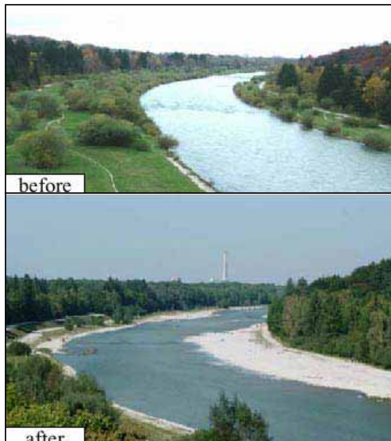
Figure 57. Exemple de tronçon restauré sur l'Isar à Munich (Binder, 2006). Niveau d'ambition R2.
