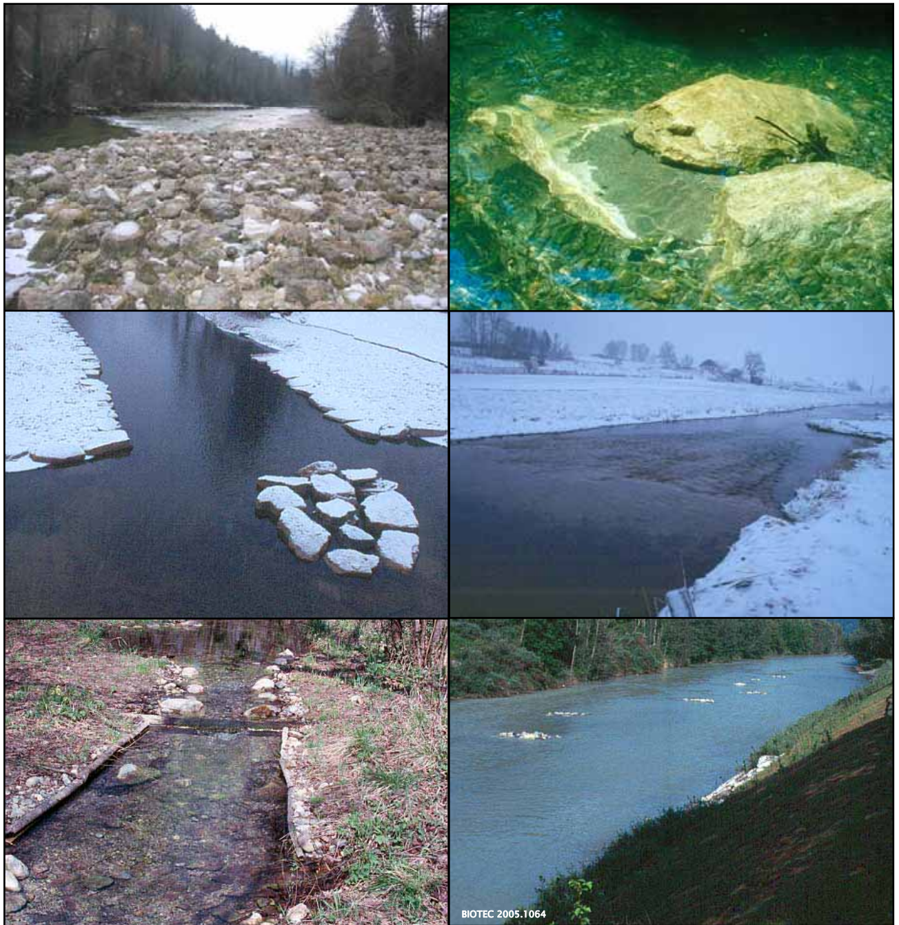
Figure 33. Différents exemples d'aménagements essentiellement piscicoles : en haut à gauche risberme en enrochements sur la Bienne, en haut à droite agencement de blocs sur la Savoureuse, au centre amas de blocs et radier artificiel sur le Drugeon, en bas à gauche caches artificielles sur un petit ruisseau affluent de l'Allondon et en bas à droite aménagements piscicoles sur l'Arve (photos Biotec et Malavoi).
