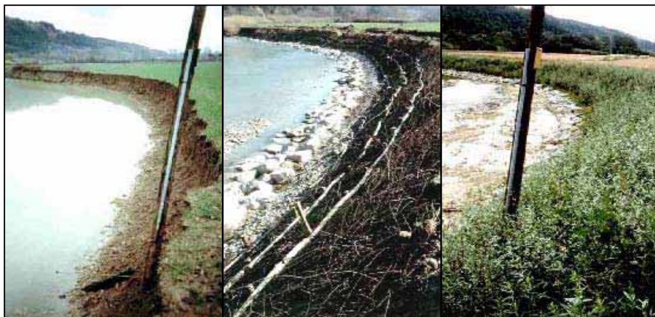
Figure 66. Rivière "Pesa" à Montelupo Fiorentino, province de Florence; illustration de technique végétale réalisée en protection de berge de cours d'eau; illustration de gauche avant les travaux, au centre en chantier puis à droite lors de la reprise végétale. Source : bureau IRIS, stratégie pour l'environnement, Maurizio Bacci ( www.irisambiente.it ).
