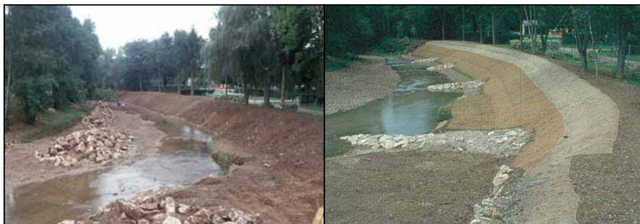
Figure 73. Terrassement des berges et démontages des enrochements sur l'illustration de gauche (30.08.01) puis récupération des blocs et mise en place d'épis déflecteurs à droite (18.09.01). Photos Biotec.
