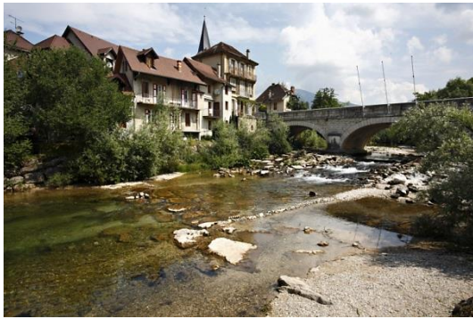
Le Guiers Vif dans la traversée des Echelles / Entre-Deux-Guiers (38)
