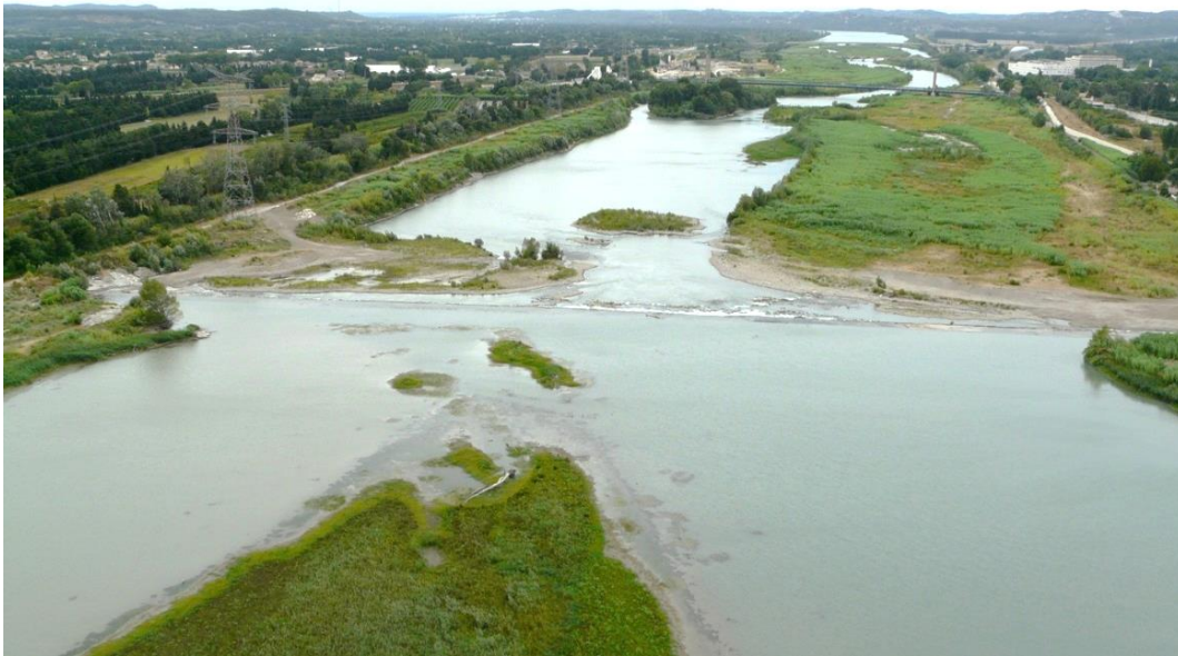
Figure 87 : Seuil sur la Durance à Avignon et colmatage du lit
