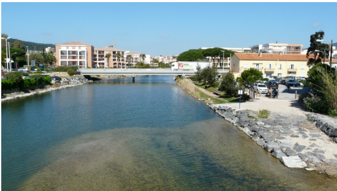
Figure 75 : Vue du site depuis l'aval, avant et après travaux de 2011-2012
