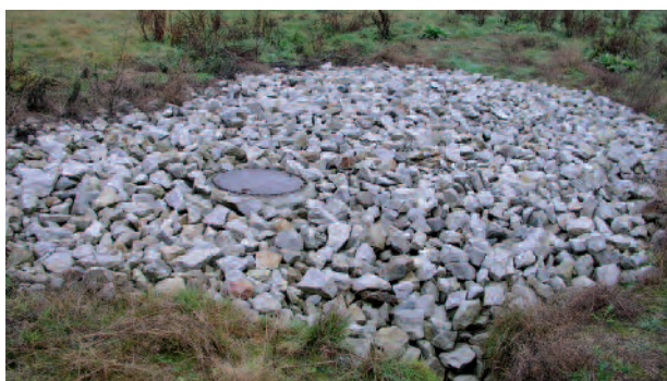
Protection/aménagement des zones de pertes.
