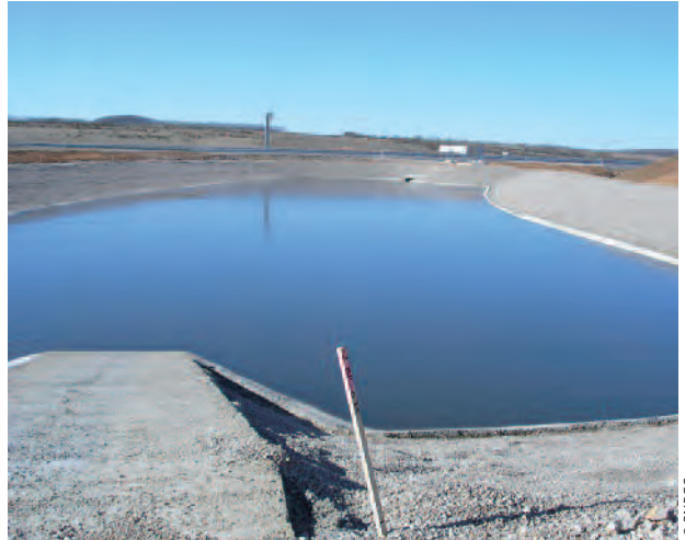
Réalisation de bassins de rétention et d'infiltration sur l'autoroute A75.
