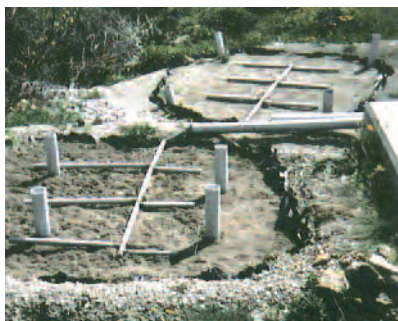
Amélioration de l'assainissement agricole : ici toutes eaux et filtre à sable pour le traitement des eaux blanches issues des salles de traite.
