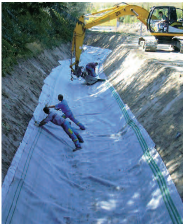
Étanchement de l'Escrebieux.
