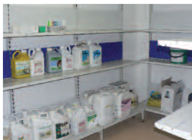
Mise aux normes de bâtiments agricoles et de locaux de stockage de produits phytosanitaires.
