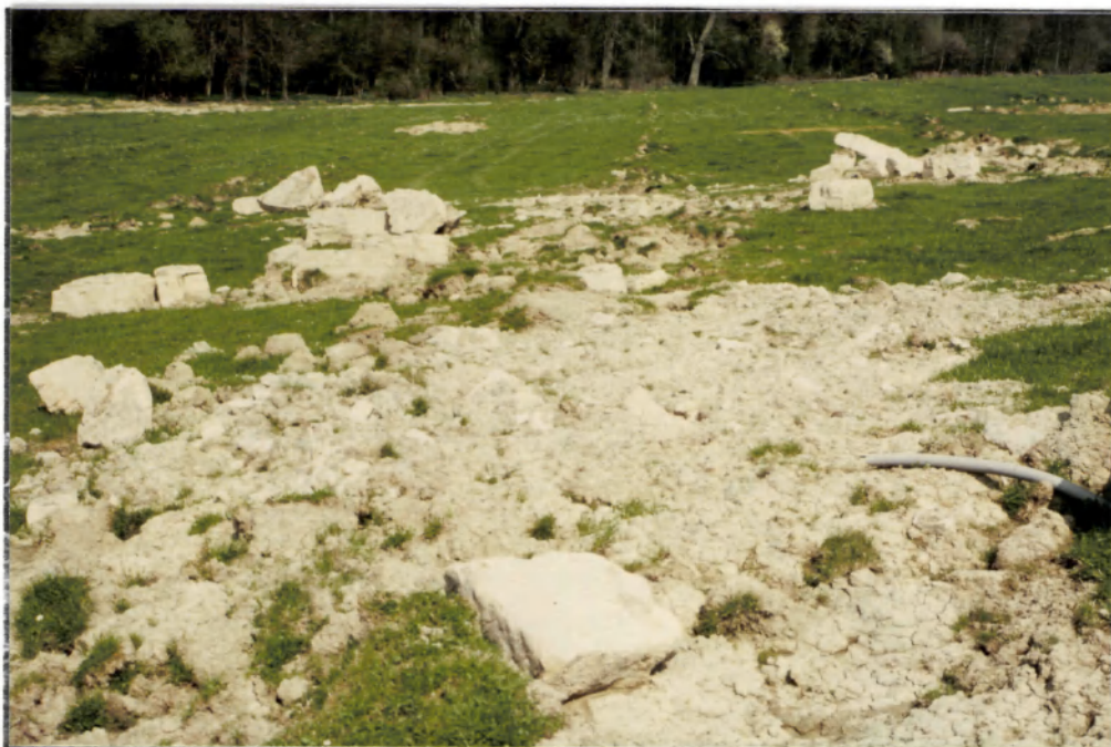
Photo 16 - Chantier de drainage dans une parcelle où blocs rocheux et marnes s'entrecourent
