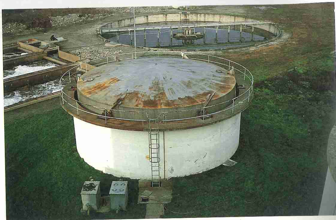
Dégradation - Protection - Restauration. Station d'épuration de Thonon-les-Bains protégeant le lac Léman de la pollution. Premier plan, cloche à gaz; second plan, décanteur; à gauche, bassin d'aération pour le traitement biologique des boues (Photo Agence de Bassin RMC).
