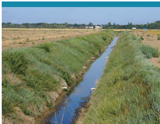
Fossé drainant traversant une zone humide
