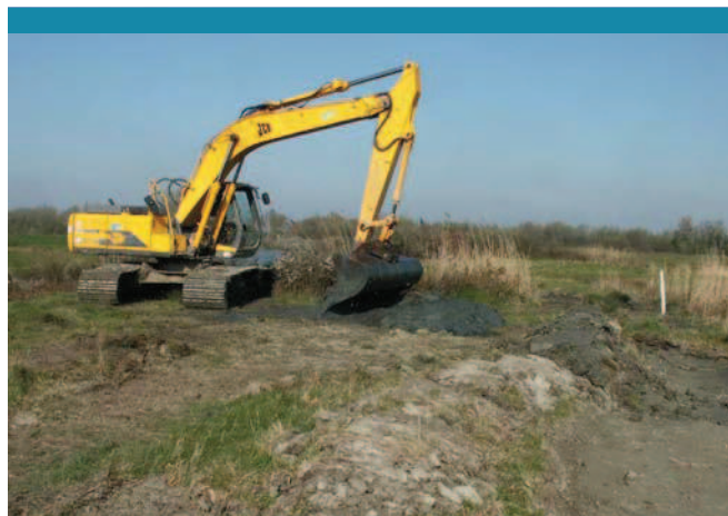
Zone humide remaniée et travaux de terrassement
