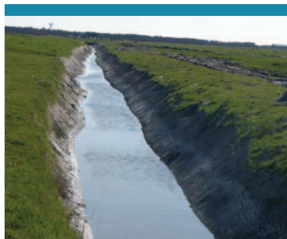
Les fossés rectilignes et profonds accélèrent l'écoulement des eaux vers l'aval et empêchent la zone humide de jouer son rôle d'expansion des crues profitable à l'épuration des eaux
