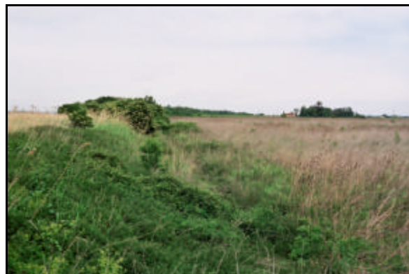
Figure 12b – Digue ouest (travaux 2000) en voie de végétalisation, vue vers la ferme Bouchaud
