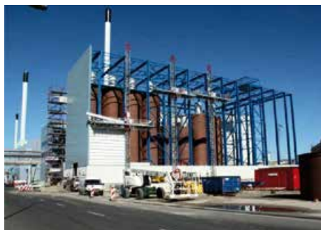
Figure 7 : Installation de stockage de farines de poisson ( http://www.iffco.net ).
