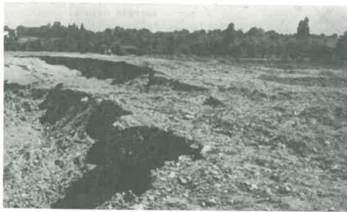
Fig 15 Détail de la rupture au niveau de la plateforme du remblai.
