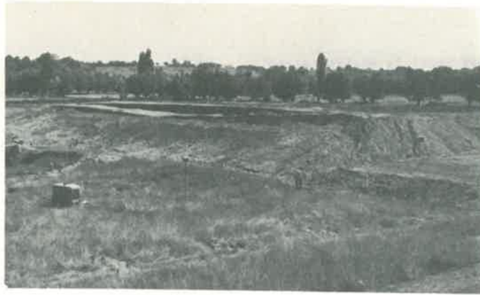
Fig 14 Rupture du remblai expérimental de St André de Cubzac.
