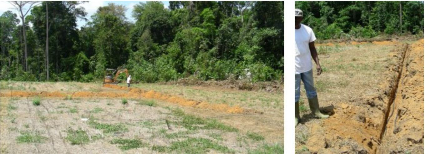
**Figure 19.** Réalisation de tranchées afin de protéger les câbles des sondes TDR et température sur le site de Combi, novembre 2010 (photographies : CETIOM).
