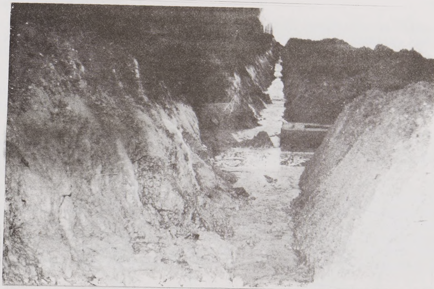
Erosion du fossé de la parcelle de Domvallier Domaine INRA de Mirecourt
